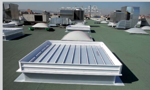
Nave Al Campo en Valdemoro, Madrid
