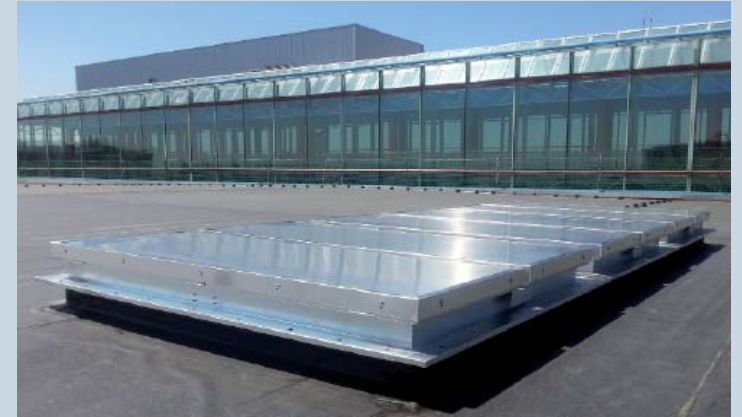
Pabellón 2 de Ifema, Madrid
