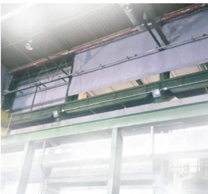
En la parte inferior de las cortinas se realiza un dobladillo para permitir la inserción de una barra de acero que favorece la estabilidad.
