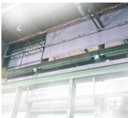
En la parte inferior de las cortinas se realiza un dobladillo para permitir la inserción de una barra de acero que favorece la estabilidad.
