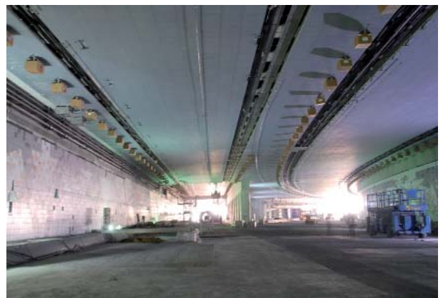
Túnel Al Salam Street, Abu Dhabi (Emiratos Árabes Unidos)
