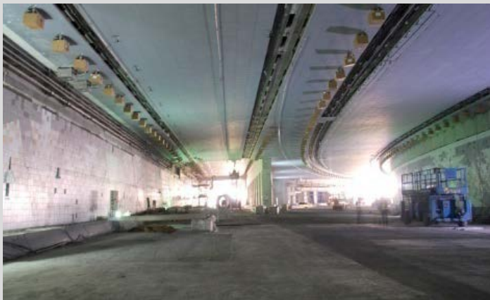
Túnel Al Salam, Abu Dhabi
