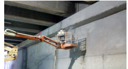
ESPAÑA MÁLAGA TÚNEL TREN ALTA VELOCIDAD - AVE
