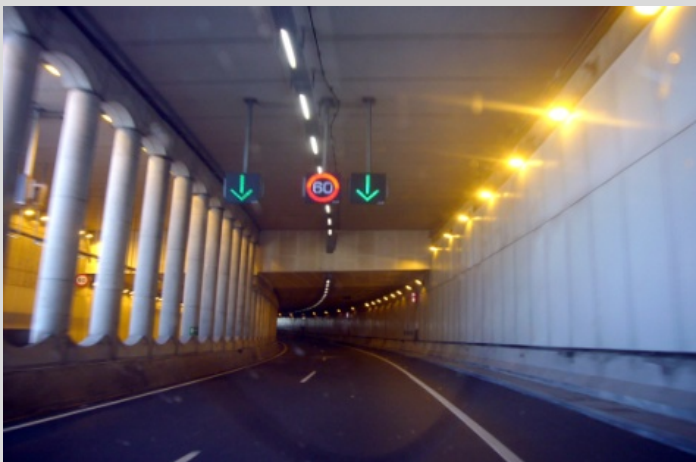
Nuevo túnel de entrada Estadio San Mamés, Bilbao
