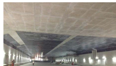
SINGAPUR SINGAPUR TÚNEL MARINA COASTAL E.XP. 482
