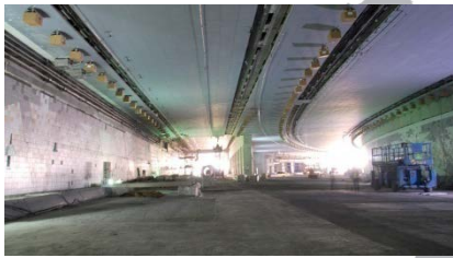
E.A.U. ABU DHABI TÚNEL AL SALAM ST.
