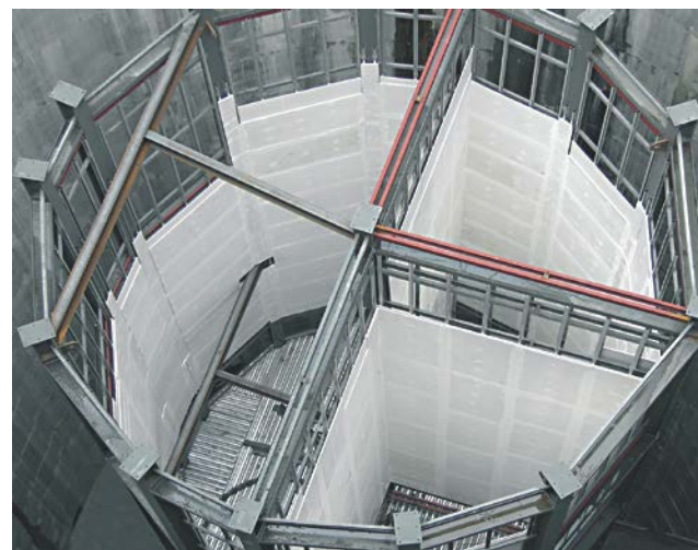
Pozos de ventilación Túnel sur M-30 BY-PASS, Madrid
