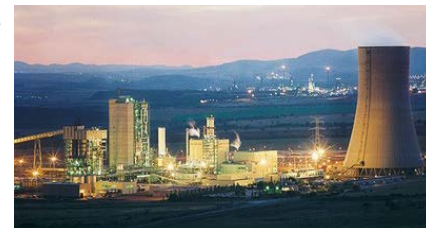
ESPAÑA PUERTOLLANO REFINERÍA REPSOL
