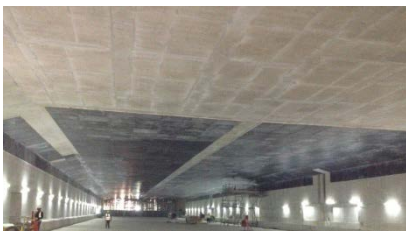
SINGAPUR SINGAPUR TÚNEL MARINA COASTAL E.XP. 482
