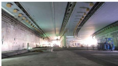
EMIRATOS ÁRABES ABU DHABI TÚNEL AL SALAM
