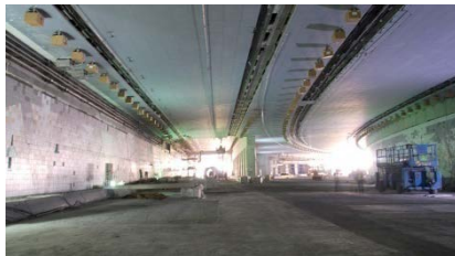
EMIRATOS ÁRABES ABU DHABI TÚNEL AL SALAM
