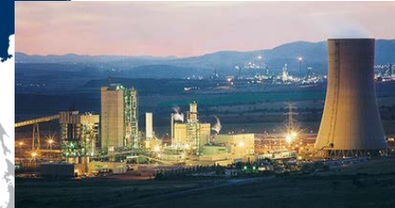
ESPAÑA PUERTOLLANO REFINERÍA REPSOL
