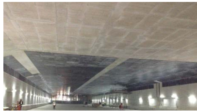
SINGAPUR SINGAPUR TÚNEL MARINA COASTAL E.XP. 482
