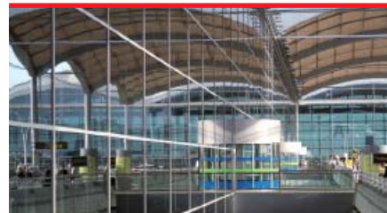
Aeropuerto de Alicante
