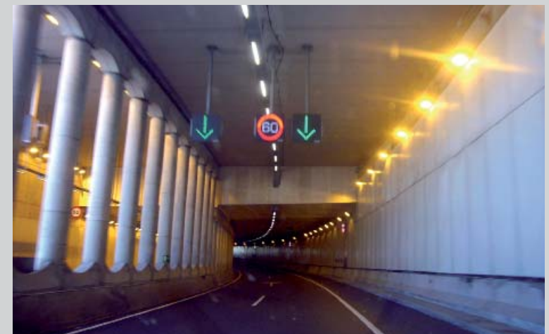
Nuevo túnel de entrada Estadio San Mamés, Bilbao
