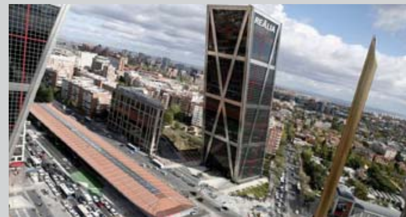
Intercambiador de transportes Plaza Castilla, Madrid
