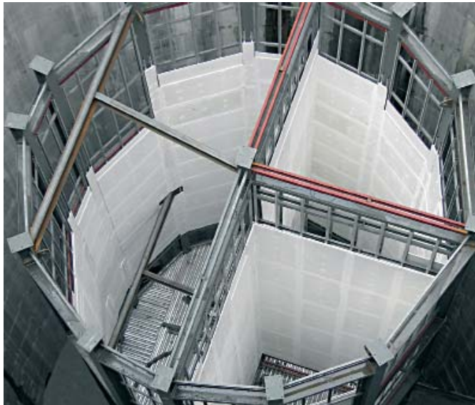
Túnel Sur BY-PASS M-30, Madrid
