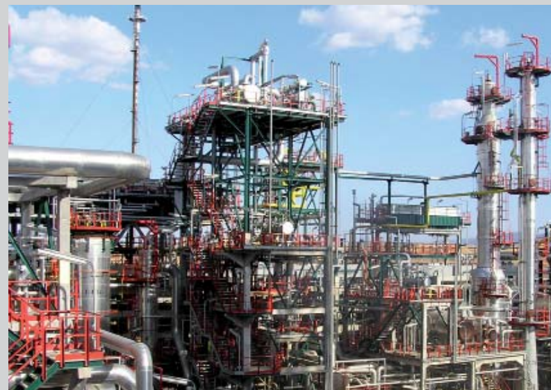
Refinería REPSOL en Puertollano, Ciudad Real
