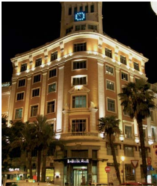
NH Paseo del Prado Hotel in Madrid
