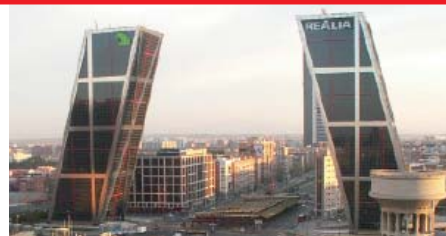
Kio Towers, Madrid
