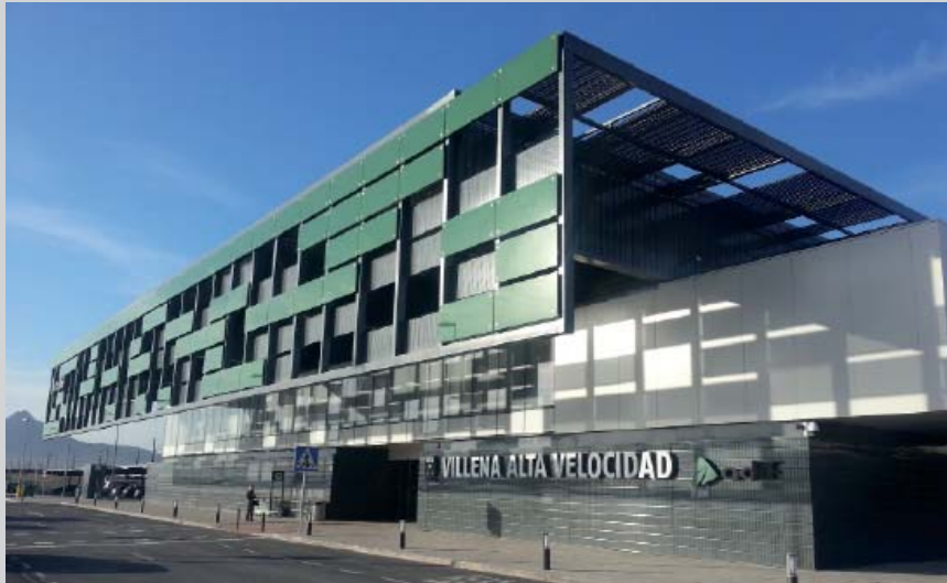
AVE in Villena, Alicante
