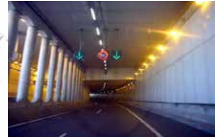
SPAIN BILBAO SAN MAMÉS TUNNEL A STADIUM
