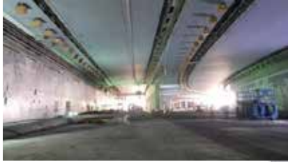
U.A.E. ABU DHABI AL RAS AL AKHDAR ST. TUNNEL
