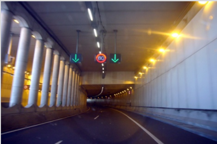
San Mamés Stadium new entrance tunnel Bilbao
