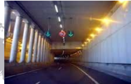
SPAIN BILBAO SAN MAMÉS STADIUM TUNNEL
