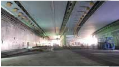
U.A.E. ABU DHABI AL SALAM ST. TUNNEL
