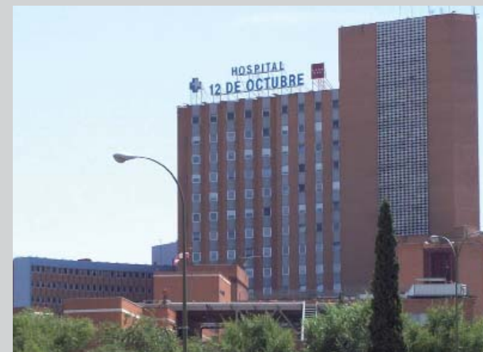
12 de Octubre Hospital, Madrid
