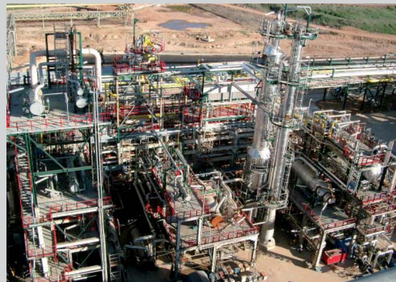
REPSOL Refinery in Puertollano, Ciudad Real
