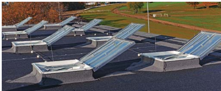
Centre Commercial Alcalá Magna à Madrid
