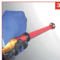
Après le remplissage de la cavité avec **Tecfill®** l'ouvrier scelle les trous réalisés sur l'ouvrage de support, avec l'élément de scellage le plus approprié (ciment, plâtre, mastic, etc.)
